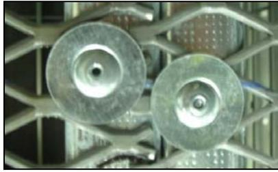
Figure 5 : Exemple de jointure de treillis entrecroisés, rivetés
